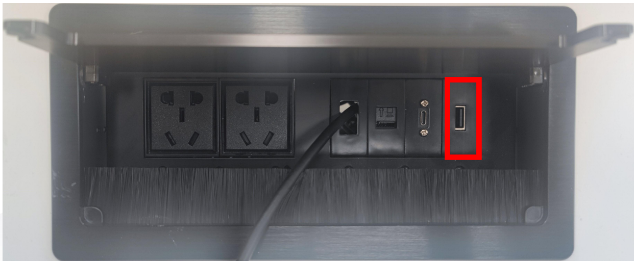
讲台桌面左侧有扩展插槽，其中有USB插口和tpyc-c接口
